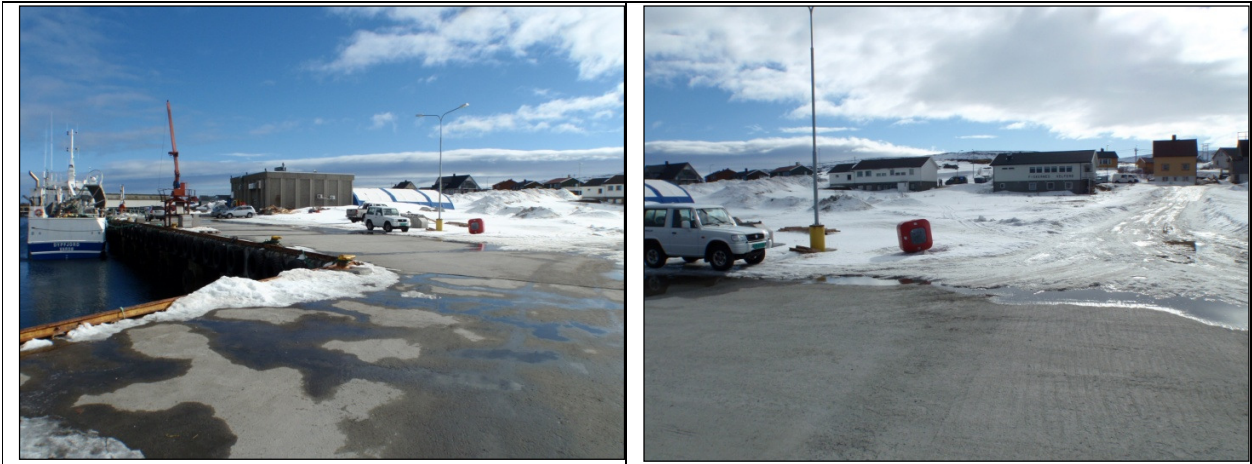
Foto (2 stk) tatt fra kommunal kaifront som viser eksisterende bebyggelse innenfor planområdet. Bilde til venstre viser Hydraulikk Finnmarks verkstedsbygning. Bildet til høyre viser eksisterende to næringsbygninger langs Fylkesvegen.
