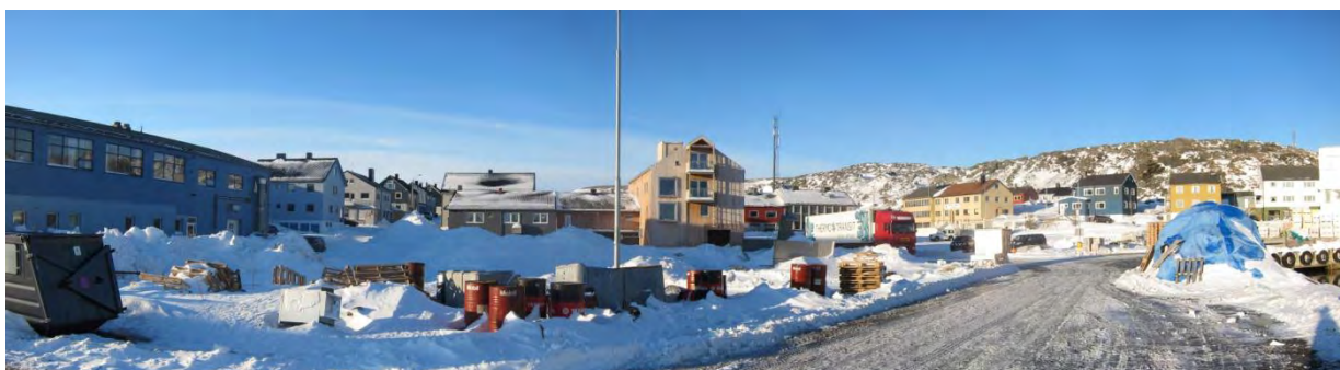
4-7 Kaiområdet slik det fremstår i dag. Området fremstår som rotete og generelt lite tilgjengelig. Området vurderes å ha et stort potensial hva gjelder utnyttelse og forskjøning.
