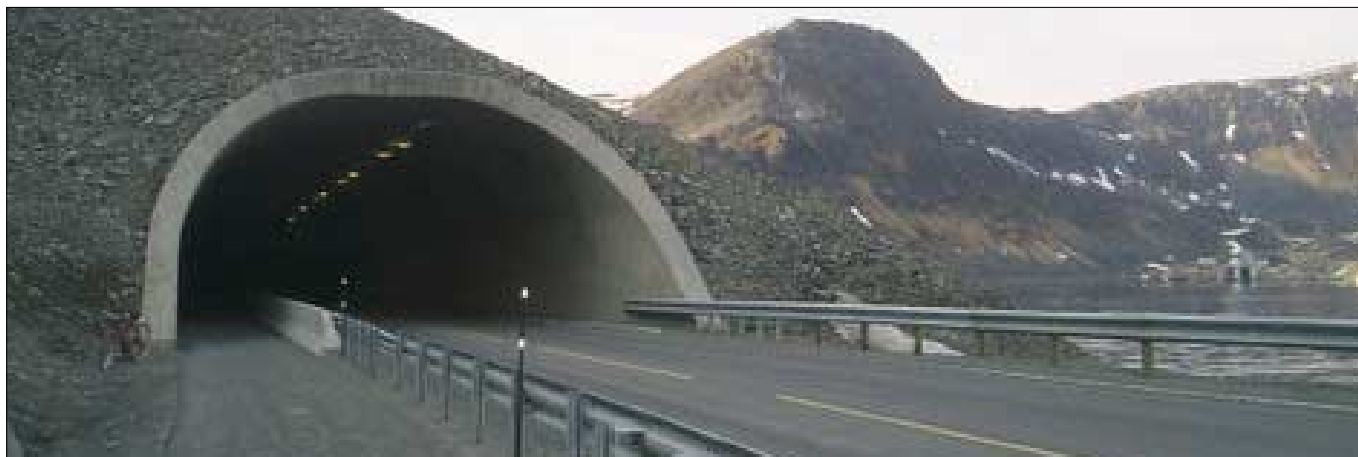
Rassikringstunnel, Nordvågen tunnel, Nordkapp kommune.
