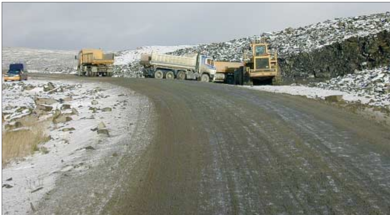
Anleggsarbeid RV888 Nordkyn.
