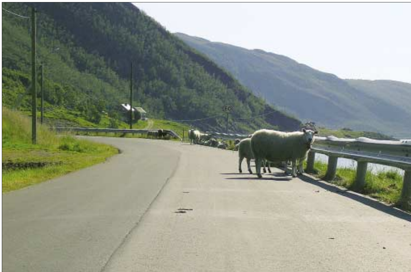
Ny asfalt FV19 Lerresfjord.
