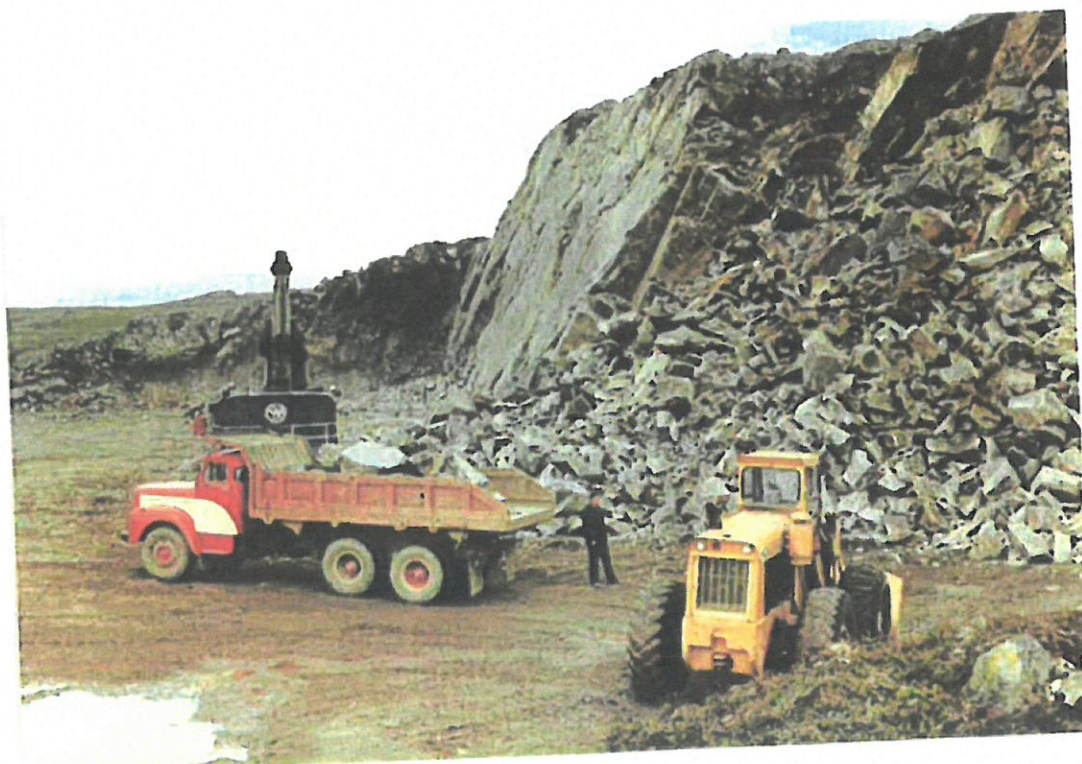
Steinbruddet i Løkvik etter at en gikk over til bildrift. De gamle derrickene er fjernet, opplastingen foregår nu med grave-maskiner og hjullastere. Stuffen er ca. 45 m. høy. Det drives på en kvartsittbenk.
