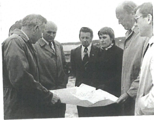
Statsminister Odvar Nordli blir orientert om utbyggingen av Berlevåg havn av distriktssjef Kjelstrup. Til høyre for statsministeren dav. ordfører i Berlevåg, senere stort.repr. Oddrun Pettersen, og hennes etterfølger som ordfører, oppsynsmann Torbjørn Torgersen.
