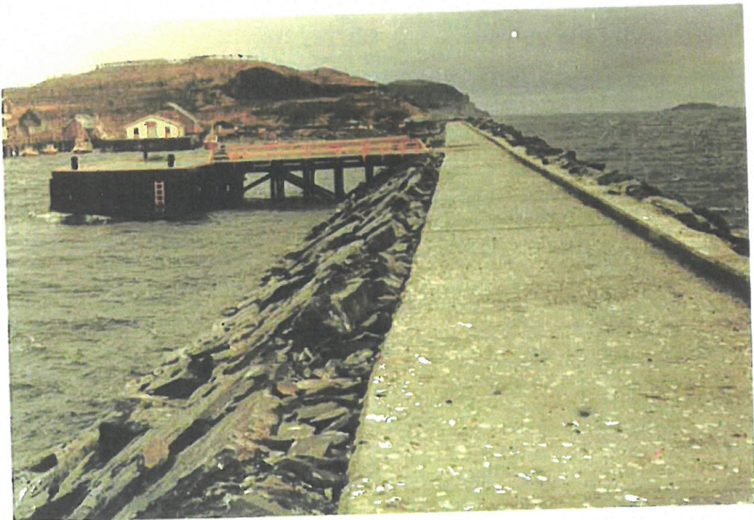
Den ferdige molo og allmenningskai sett utenifra inn mot landfestet. Innsiden er steinplattet. P.g.a. minimal overvasking er det ikke bygget eller støpt brystvern.
