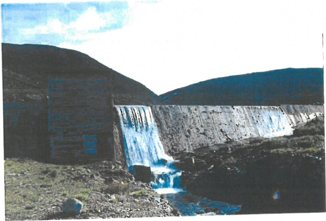
Berlevåg vannverk. Dammen for magasinet i Løkvikdalen.
