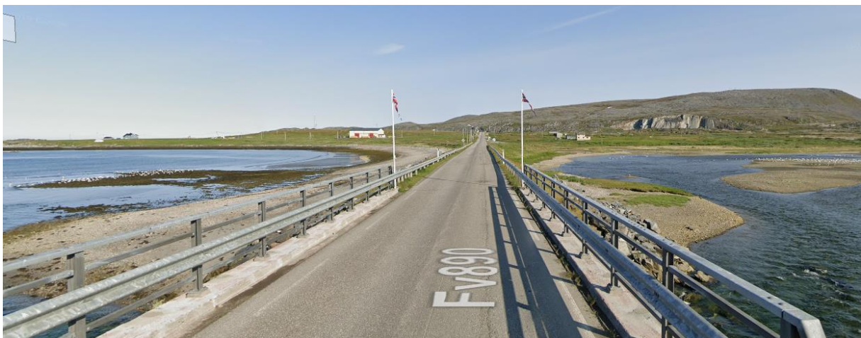
Figur 7 - Revneshaugen til venstre for fv. 890 med ØFAS-stasjonen. Foto: Google.
