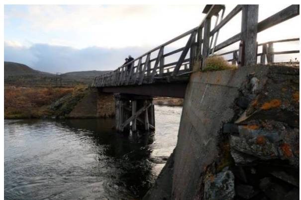
Figur 20 - Jernbanebrua. Foto: Bjarne Mjelde
