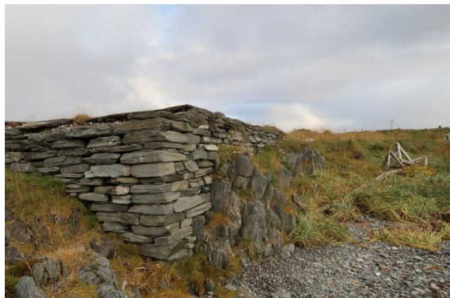
Figur 10 – Kaianlegg. Foto: Bjarne Mjelde
