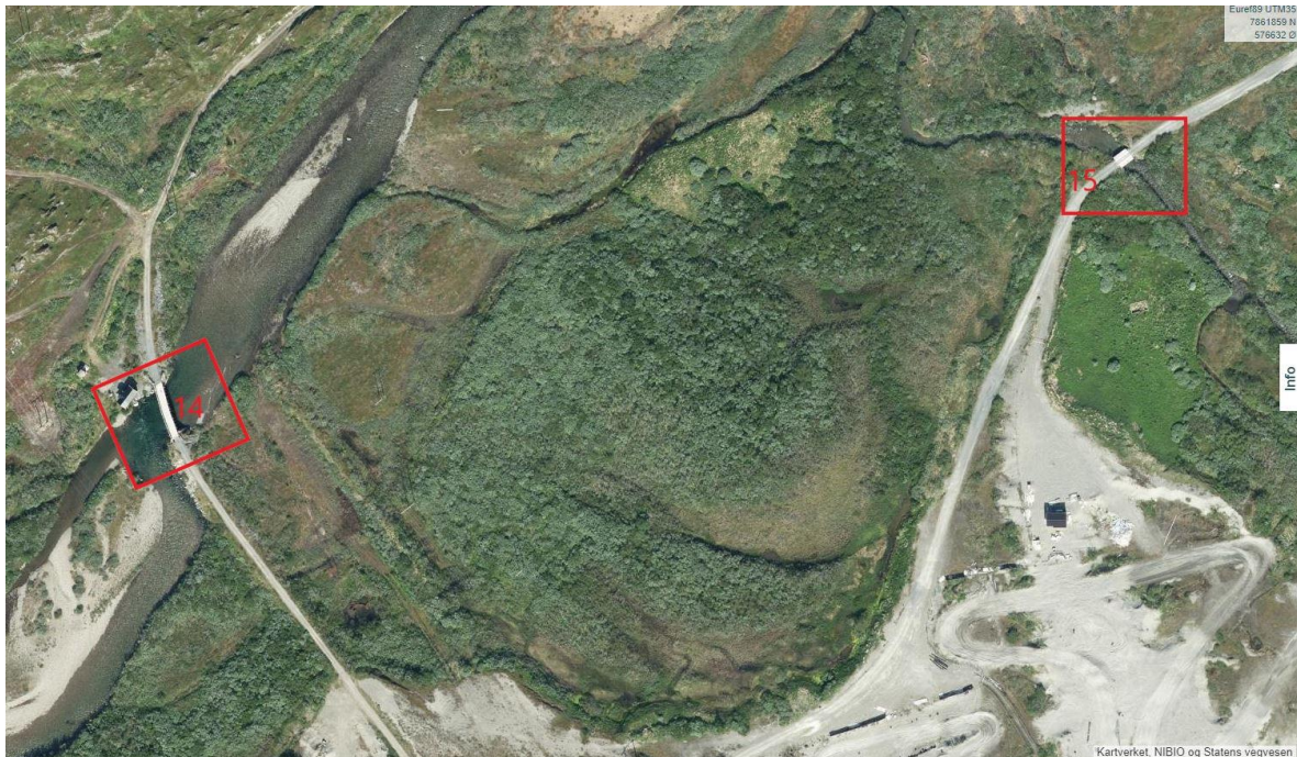
Figur 19 - Jernbanebrua og Finabrua. Foto: Norgeskart.no
