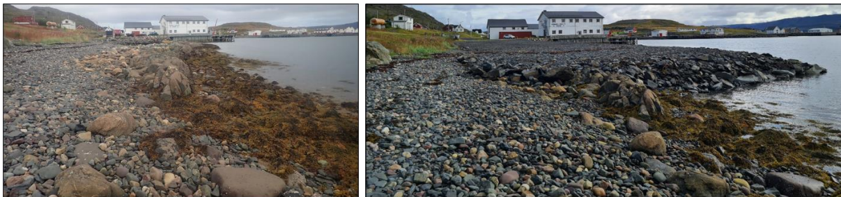
Figur 3. Foto fra omsøkt område: T.v. før utfylling (foto: Rambøll 31.08.21) og t.h. etter utfylling (foto: Berlevåg kommune 31.08.22)
